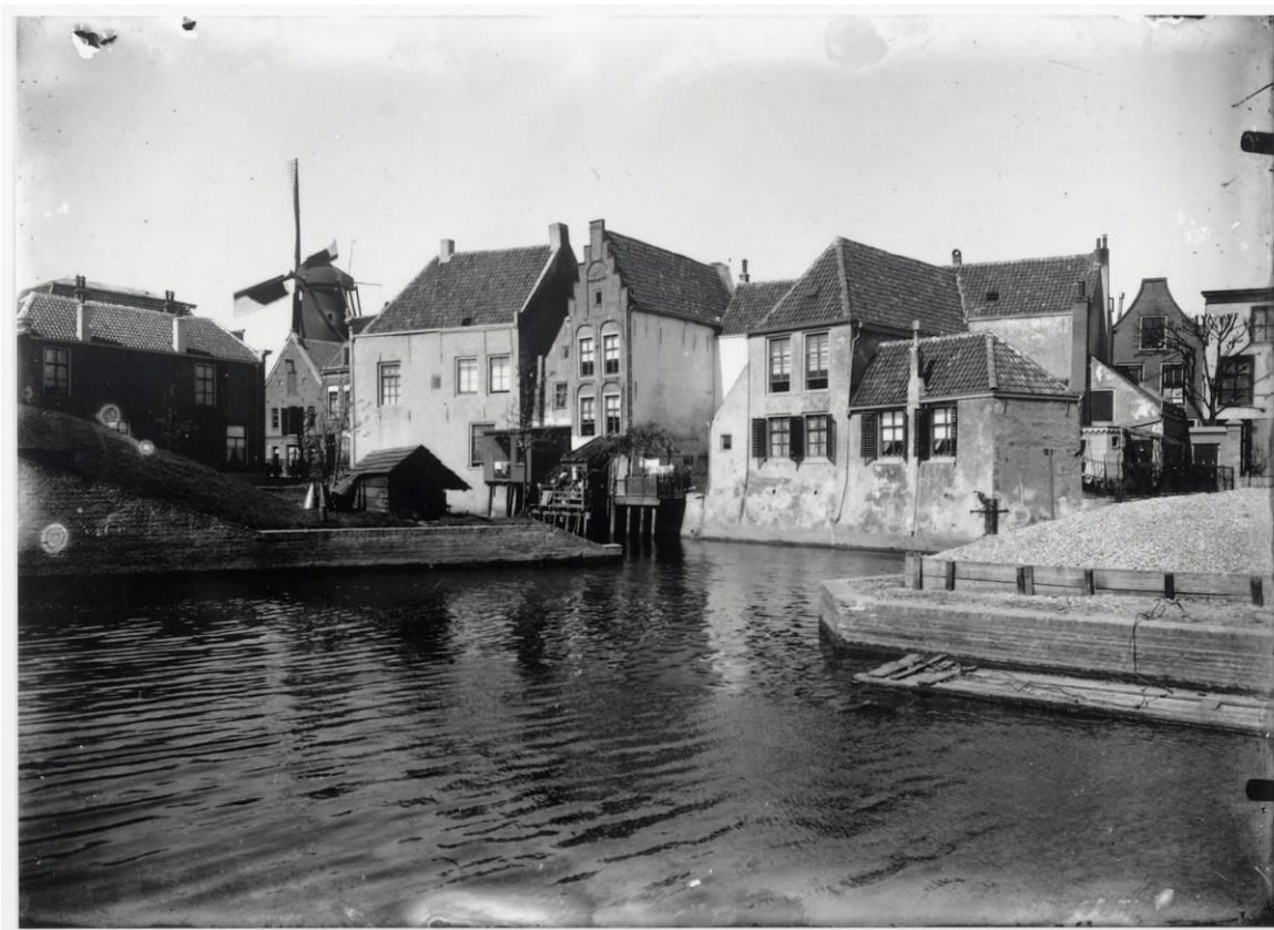
Afb. 11 De achterkant van de huizen aan de Voorhaven staat nog in het water. Het huis 'Gapenburg' rechts en links korenmolen 'De Hoop', die werd afgebroken in 1918. Foto C. Vreedenburgh jr., ca. 1915
