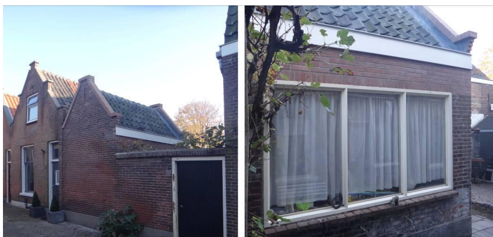
Afb. 4. Werkplaats(je) achter woonhuis Oude Haven 31, hoek Provenierstraat (J.F. de Rooij), links aanzicht in de Provenierstraat, rechts aanzicht in de tuin. Gerestaureerd omstreeks 2012. Uitkijkriching west, op eigen besloten terrein.
