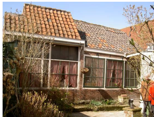
Afb. 2. Oude Haven 8. Werkplaats met uitbreiding, staande achter het woonhuis (Verroen, Dieges, Van de Hoff). Uitkijkrichting oost, op besloten eigen terrein/tuin.
