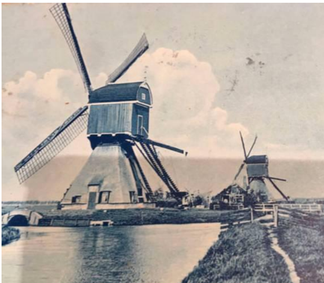
Afb. 2 De Hoflandsche Molens. In de omgeving van deze molens, op de toenmalige grens tussen Schoonhoven en Willige-Langerak, is Dirk Pelt (Va) op 1 november 1855 op treurige wijze om het leven gekomen (afb. 3). De molens zijn omstreeks 1927 afgebroken. Het pad op de voorgrond is het tegenwoordige Vinkenpad in Schoonhoven, langs het voormalige elektrische gemaal K. Vink, thans Rijksmonument.
