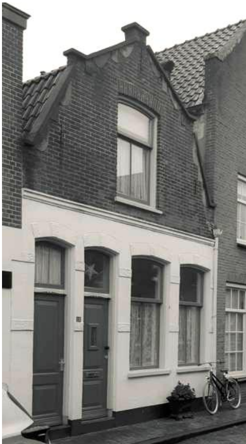
Afb. 12 Woonhuis Carmelietenstraat 13. Hier woonde en werkte Bartholomeus Willem Pelt met zijn gezin in 1915. Kenmerkend voor deze zilversmidswoning is de tweede voordeur, die via een inpandige gang toegang gaf tot de werkplaats. Zo hoefde personeel of leveranciers met stoffige zakken kolen e.d. niet door het huis naar de werkplaats. Foto Ferry Mol, 2021.
