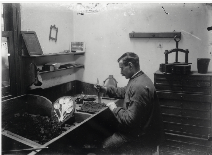
Afb. 3 'Het gereedmaken van een gietvorm, het instampen der vochtige aarde. Links een gegoten stel'.
