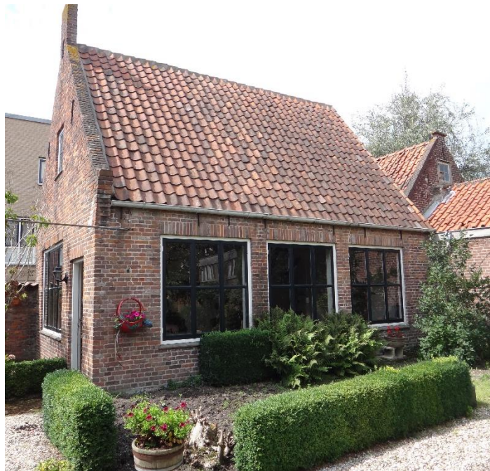
Afb. 17 De twee nieuw opgemetselde gevels van de ‘werkplaats 1947’. In afwijking van de traditionele grote raampartij van een zilversmidswerkplaats heeft architect Died Visser stenen ‘penanten’ tussen vierkante ramen geplaatst. De zoldervloer werd verhoogd; de bestaande betonvloer behouden. In de westmuur (afb. 18) werden een raam en toegangsdeur dichtgezet met metselwerk. SAMH, ac. 1015, Schoonhoven, Bouwvergunningen, inv.nr. 1194, 16 mei 1947. Foto's RKa 2011.
