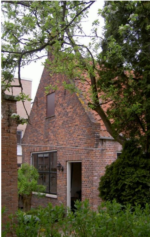
Afb. 17 De twee nieuw opgemetselde gevels van de ‘werkplaats 1947’. In afwijking van de traditionele grote raampartij van een zilversmidswerkplaats heeft architect Died Visser stenen ‘penanten’ tussen vierkante ramen geplaatst. De zoldervloer werd verhoogd; de bestaande betonvloer behouden. In de westmuur (afb. 18) werden een raam en toegangsdeur dichtgezet met metselwerk. SAMH, ac. 1015, Schoonhoven, Bouwvergunningen, inv.nr. 1194, 16 mei 1947. Foto's RKa 2011.
