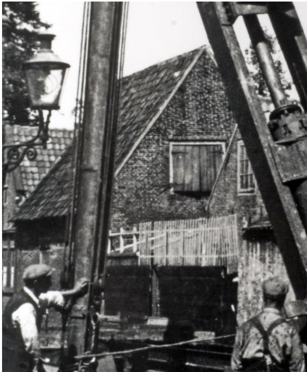
Afb. 13 De ‘schuur’ zoals te zien op een foto van het heiwerk ten behoeve van de Loodwitfabriek HBB, omstreeks 1935.
