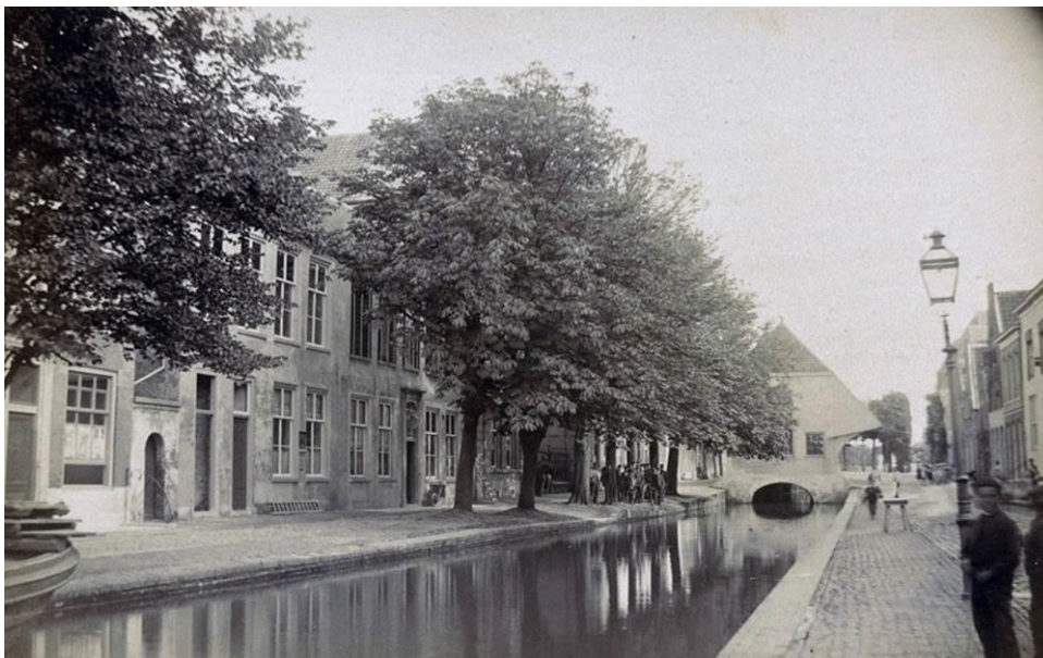
Afb. 22 Oude Haven 9 en 11 als postkantoor, vóór 1899. De deur van het postkantoor is open, de handkar ernaast voor transport van zware pakketten. Tussen de ramen links hangen de brievenbussen aan de gevel; de bovenste voor brieven, de onderste voor drukwerken. “Drukwerken, aangetroffen in de bus bestemd voor brieven, zullen worden behandeld als ongefrankeerde brieven”, zo waarschuwde directeur Nahuijs zijn cliëntèle in 1874. (Schoonhovensche Courant, 3 mei 1874 p. 1). Foto Coll. GW.
